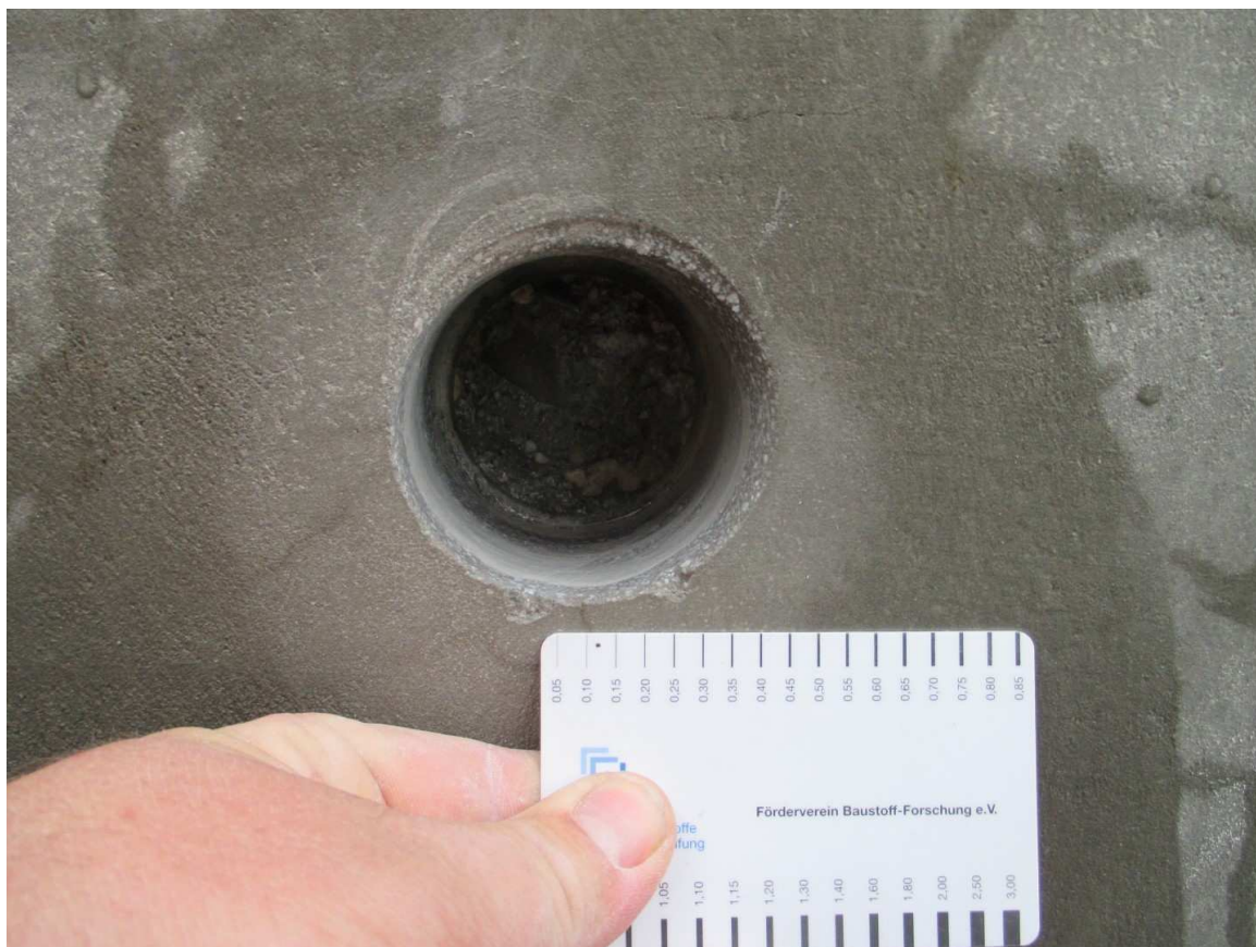
Bild 7: Ansicht der Rissbreite 0,1 mm bei Bk2
