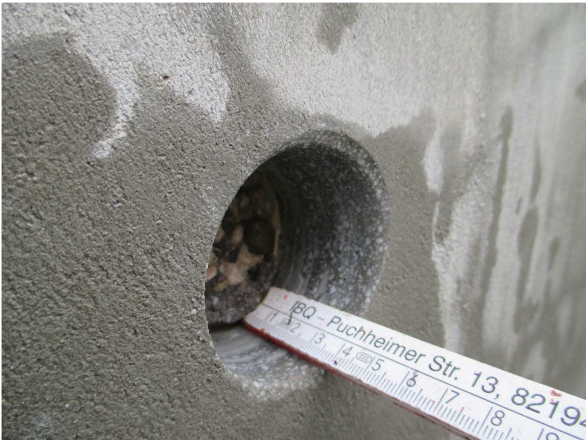
Bild 12: Ansicht Kernloch Bk3 mit sichtbarem Altbeton im Hintergrund
