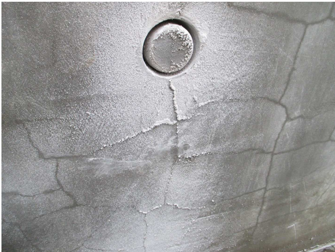
Bild 6: Bk2 vor dem Abbruch, sichtbar: anhaftender Bohrstaub an feuchten Rissen
