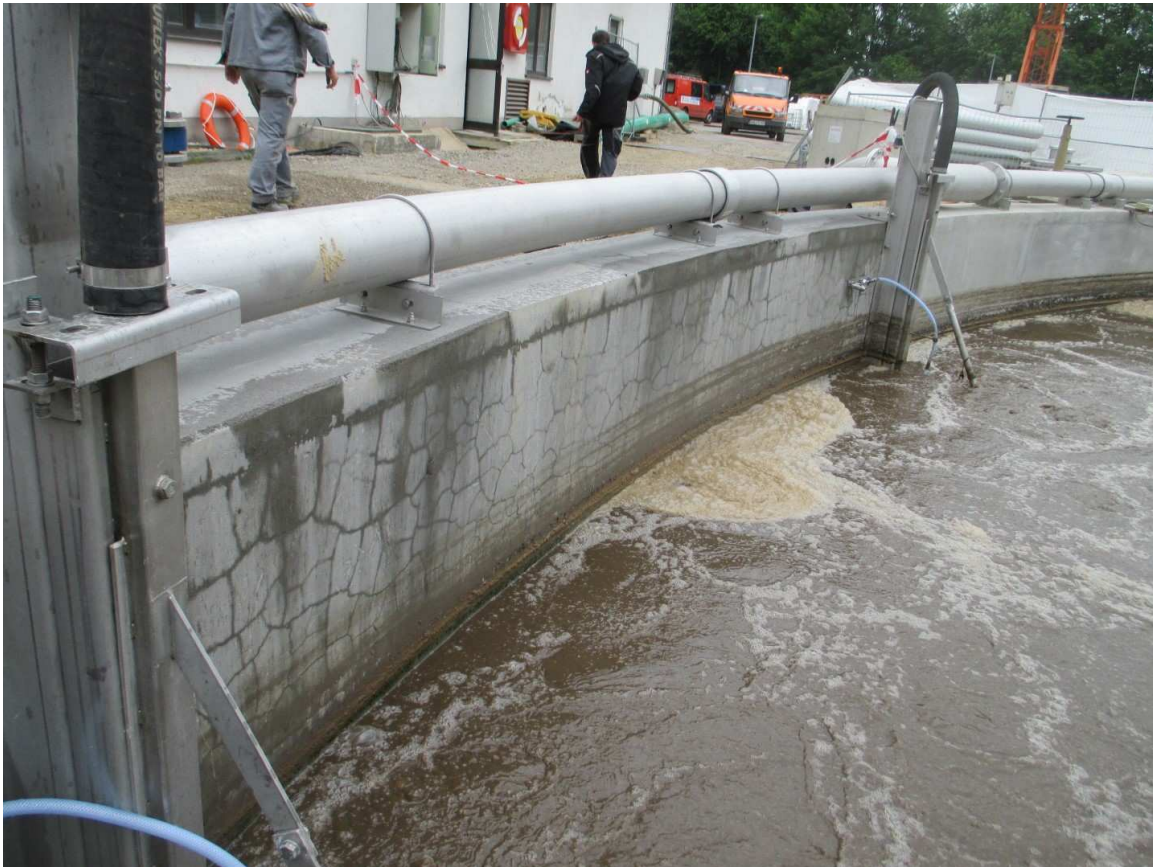
Bild 15: Ansicht Lage des Bohrkerns Bk3 aus Kanzel des Teleskopladers und allgemeines Rissbild
